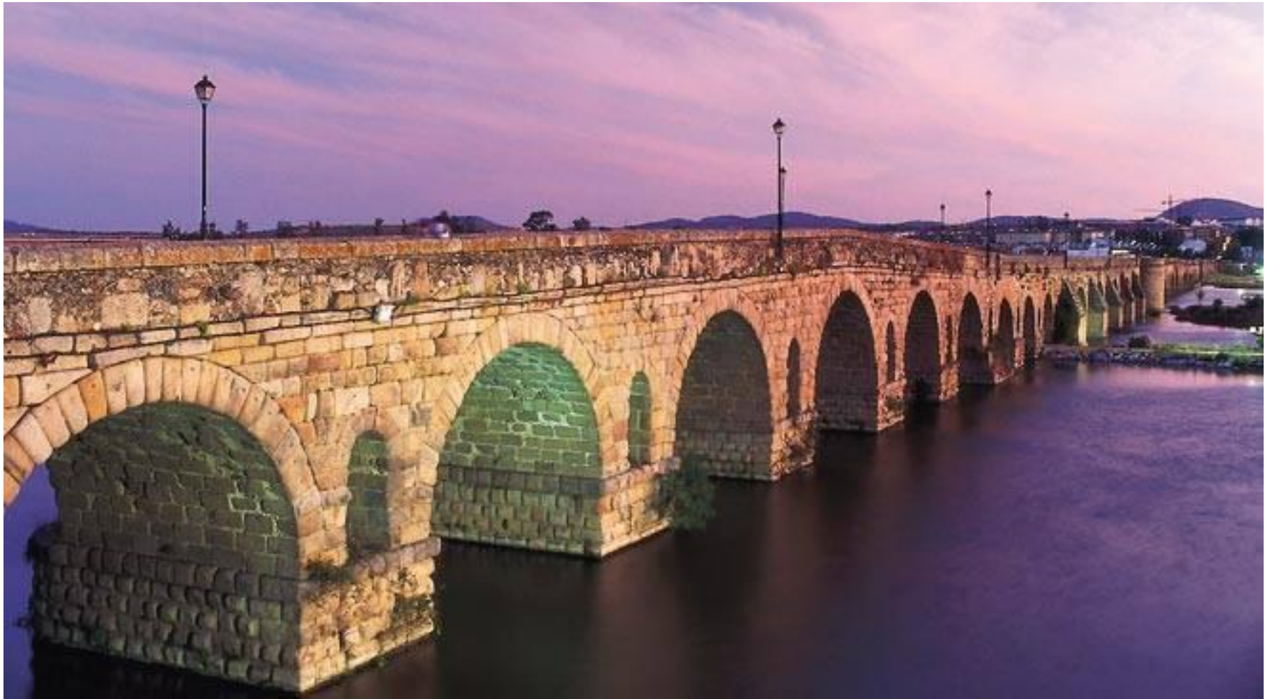
El Guadiana a su paso por Mérida
